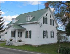
date estimée 1860 date connue type architectural Maison à toit à deux versants droits d'inspiration néoclassique IMG_3599.jpg
