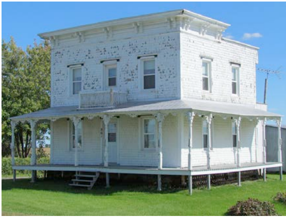
Un édifice à fonction résidentielle, le 861, rang du Boulevard (Route 138). IMG_3794.jpg
