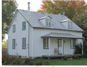
date estimée 1870 date connue type architectural Maison à toit à deux versants droits d'inspiration néoclassique IMG_4687.jpg
