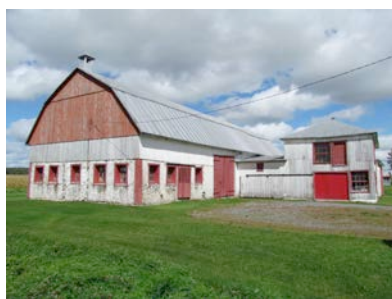
Un bâtiment secondaire au 590, rang Saint-Joachim. IMG_3504.jpg
