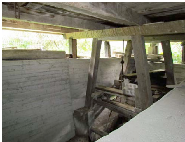
Mécanisme apparent d'un ancien moulin au 90, rang York. IMG_3460.jpg
