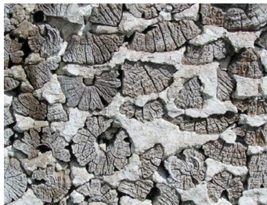
Détail de la structure en billes sur billes au 590, rang Saint-Joseph. IMG_3505.jpg
