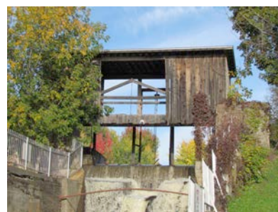
Des vestiges sur le site de l'ancien moulin Savoie au 2180, rue Buteau. IMG_4664.jpg
